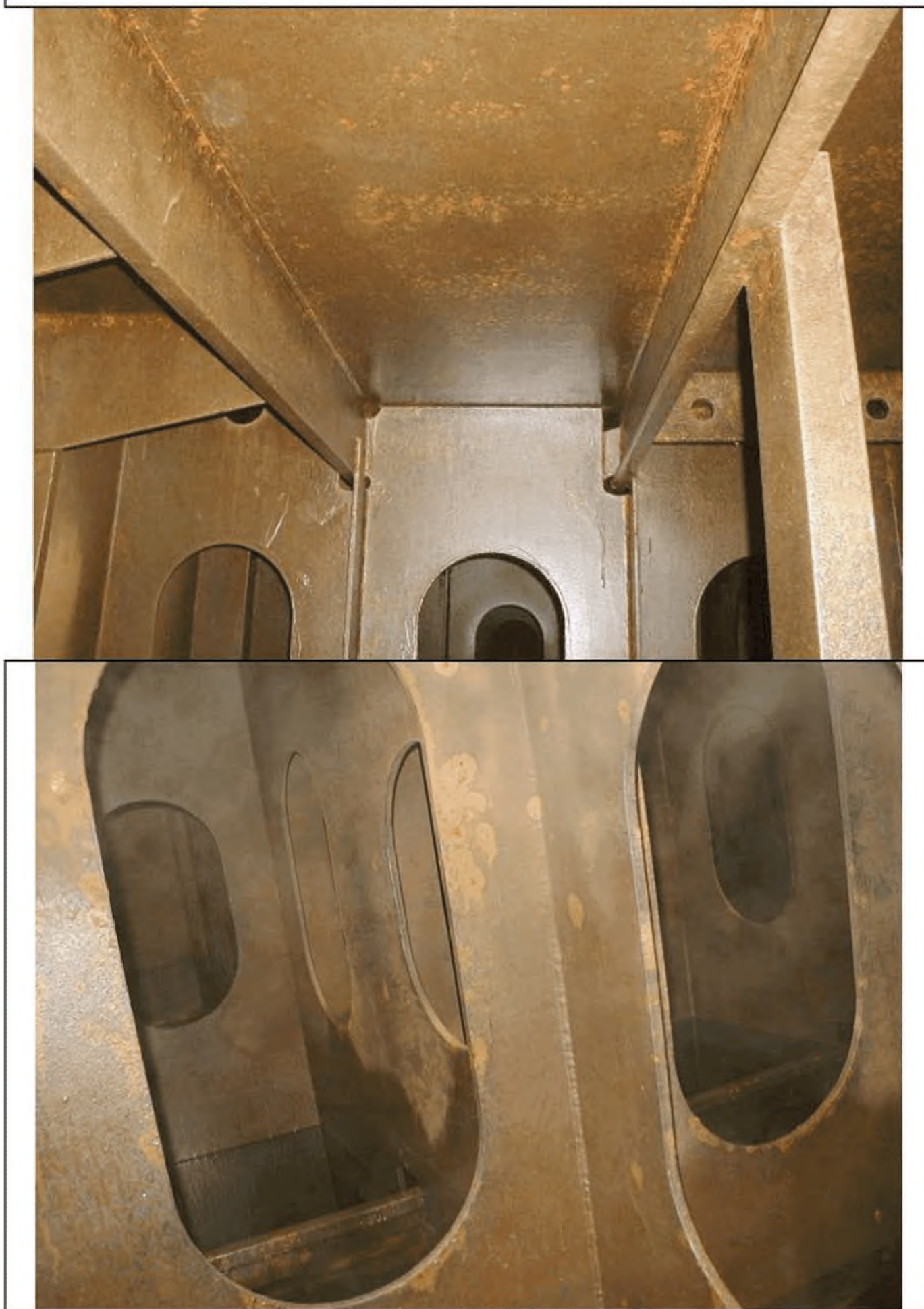
ХОРОШЕЕ СОСТОЯНИЕ ПОКРЫТИЯ
