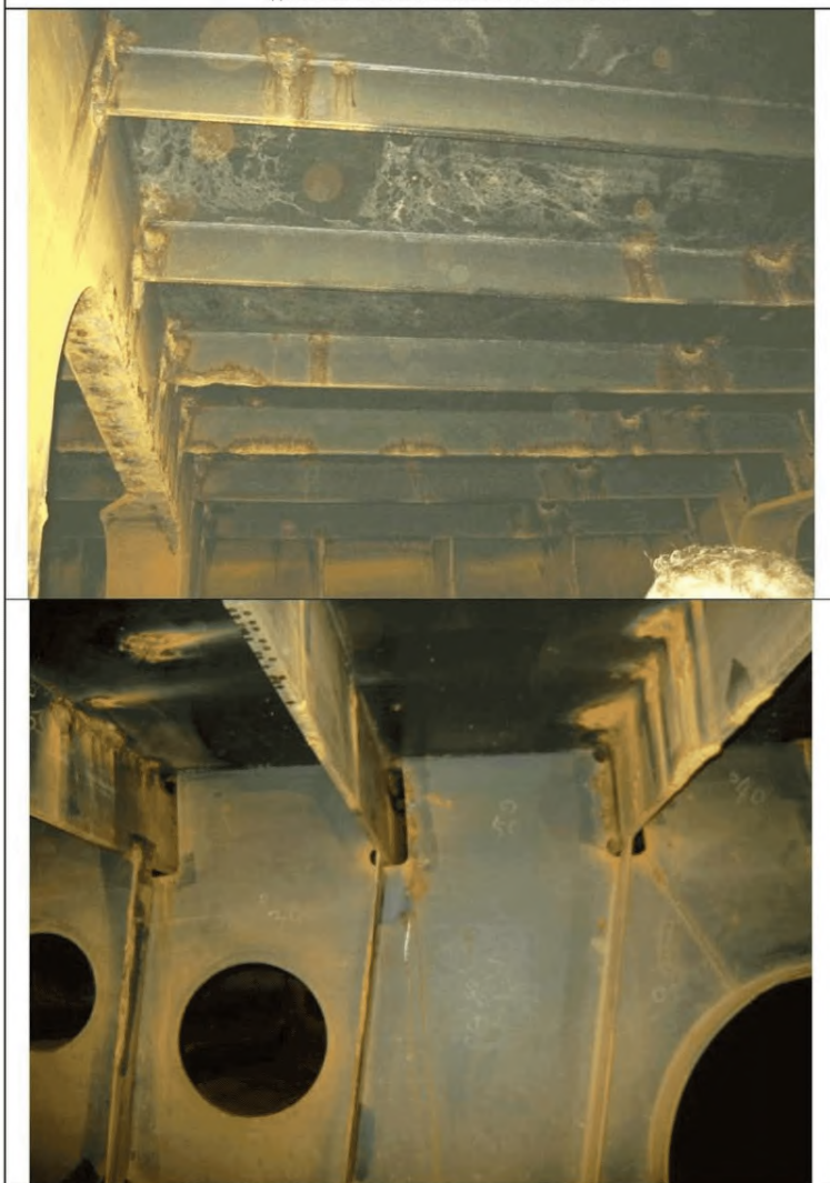
УДОВЛЕТВОРИТЕЛЬНОЕ СОСТОЯНИЕ ПОКРЫТИЯ
