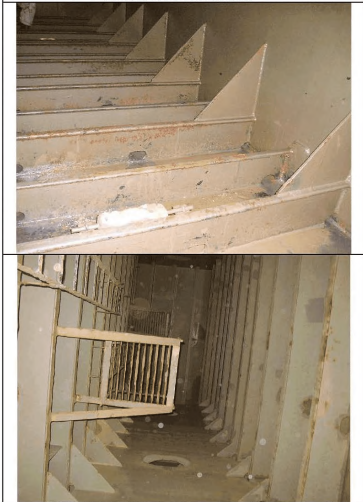
ХОРОШЕЕ СОСТОЯНИЕ ПОКРЫТИЯ
